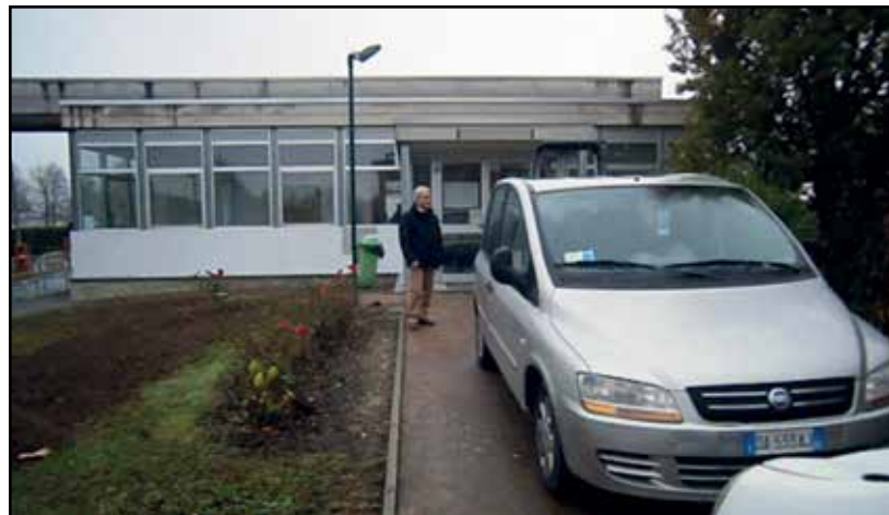
Lavori in corso alla sede dell'Avis, ingresso ospedale.
